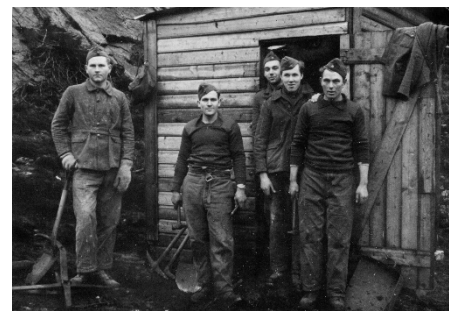
Reier Tengesdal t.v. ute i arbeidstjeneste i AT-leiren på Eikeland. Her ved ei anleggsbrakke ute i terrenget. Foto: Jørgen Tengesdal
